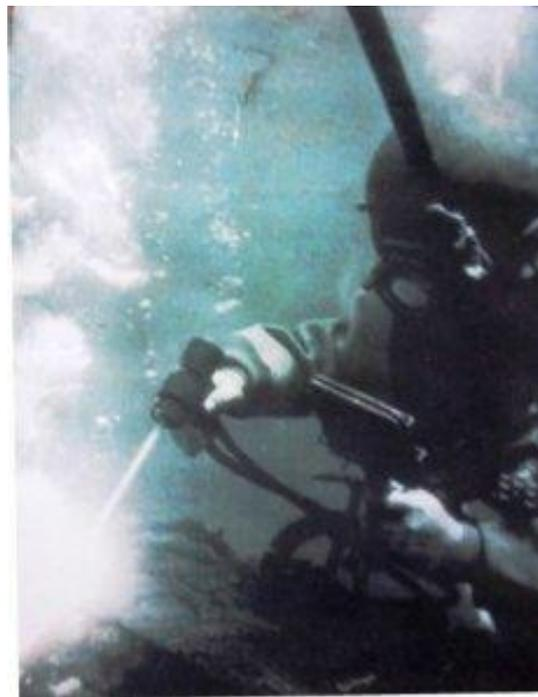
Pour éviter ce gros inconvénient l'entreprise Arcair met sur le marché dès 1971 la SEA-CUT.1, une électrode composée d'un mélange de carbone et de graphite et qui ne comporte plus qu'une simple protection isolante à base de plastique.
