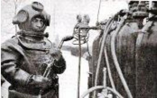
Le principe de fonctionnement est plus ou moins identique à celui de son prédécesseur, c'est - à - dire que l'essence qui ne peut être détendue est amené jusqu'au bec du chalumeau par l'intermédiaire d'azote comprimé où elle est ensuite pulvérisée dans l'oxygène.
