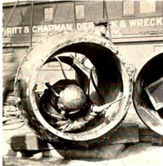
De plus, la conduite était en fonte donc difficilement oxydable et les épaisseurs variaient de 30 à 80 mm.
